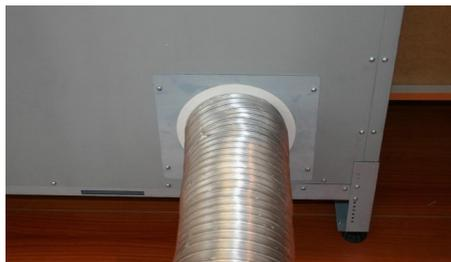
Lateralmente e sotto invece è possibile il collegamento di un tubo diametro 150mm su ambo i lati e a preferenza su due altezze (Fig. 1). L'aspirazione ai lati è penalizzata e si consiglia l'utilizzo solamente quando le altre uscite risultano assolutamente non utilizzabili. Dopo aver deciso la posizione del supporto, svitare le viti della cappa in corrispondenza dello stesso. Fissare il supporto e raccordo in dotazione riavvitando le viti della cappa. Successivamente collegare il tubo.
