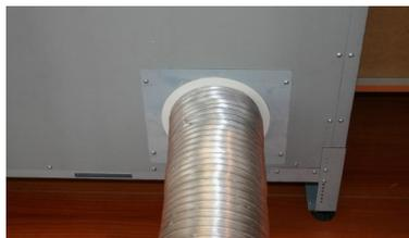
Bočně a dospodu je možné připojit trubici o průměru 150 mm, na obě strany, libovolně do jedné do dvou výšek (Obr. 1). Odsávání po stranách je nevýhodné, a proto ho doporučujeme pouze v případě, kdyby absolutně nebylo možné použít ostatní výstupy. Když se rozhodnete, do jaké výšky umístíte opěru, vyšroubujte příslušné šrouby na digestoři. Namontujte opěru se spojkou, která se dodává spolu s digestoři. Následně připojte trubku.
