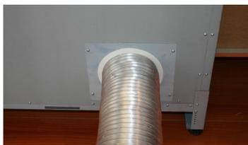
Op de zijkanten en onderaan kan een buis met een diameter van 150 mm aangesloten worden, bij voorkeur op twee verschillende hoogtes (afb. 1). De zijdelingse aanzuiging is beperkt en wij adviseren enkel het gebruik ervan als de andere uitgangen absoluut onbruikbaar zijn. Nadat de plaats van de steun werd bepaald, de schroeven van de kap, in overeenstemming met de steun, losdraaien. De steun en het toebehoren bevestigen door de kapschroeven vast te draaien. Vervolgens de buis verbinden.
